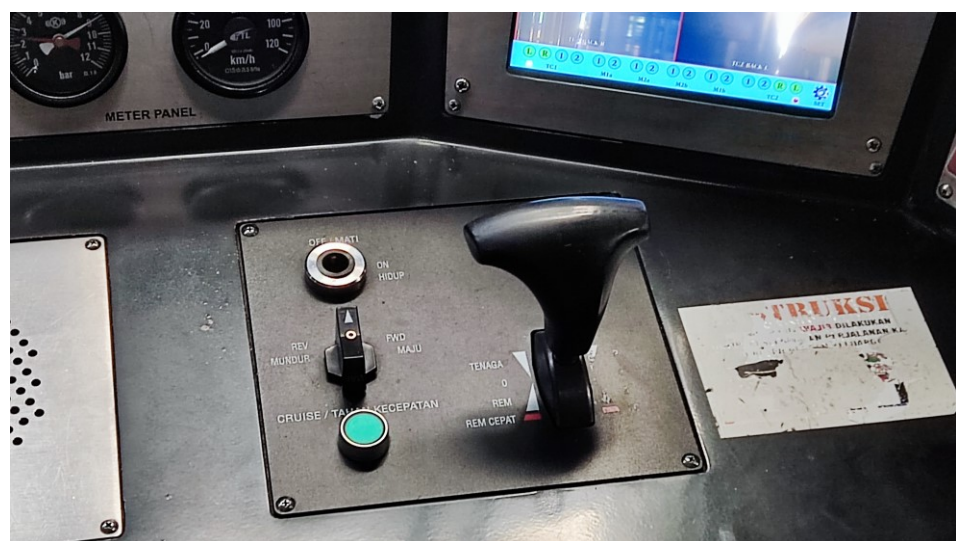
Gambar 16. Master Controller di kabin kereta TC2 pada TS-1 Kereta Api Bandara
