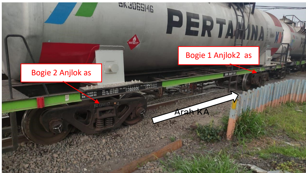
Gambar 2. Kondisi gerbong ke-5 KA 2636F (GK 3065146) yang mengalami anjlok 4 as
