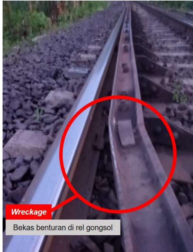
Gambar 4. Tanda benturan di rel gongsol di Km 3+853,5
