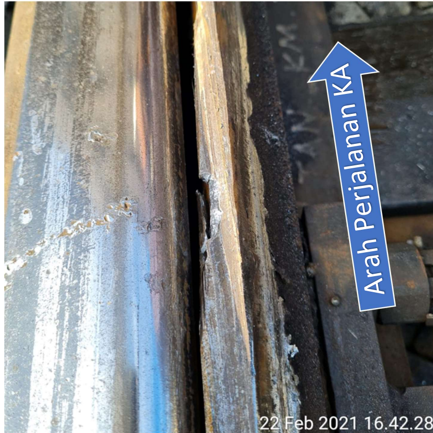
Gambar 6. Kondisi lidah Wesel 23B1 saat kejadian anjlokkan
