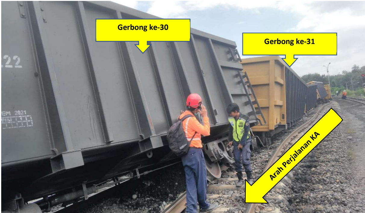
Gambar 1. Kondisi gerbong Ex. KA 3077 yang mengalami anjlokkan
