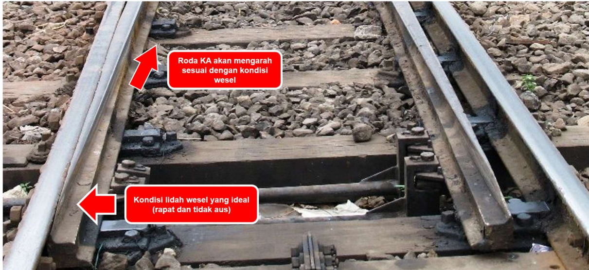
Gambar 17. Kondisi lidah weasel yang ideal (dapat mengarahkan roda KA dengan baik)
