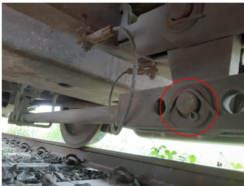
Gambar 13. Penggunaan komponen washer dengan diameter yang lebih besar dibandingkan dengan diameter center pin
