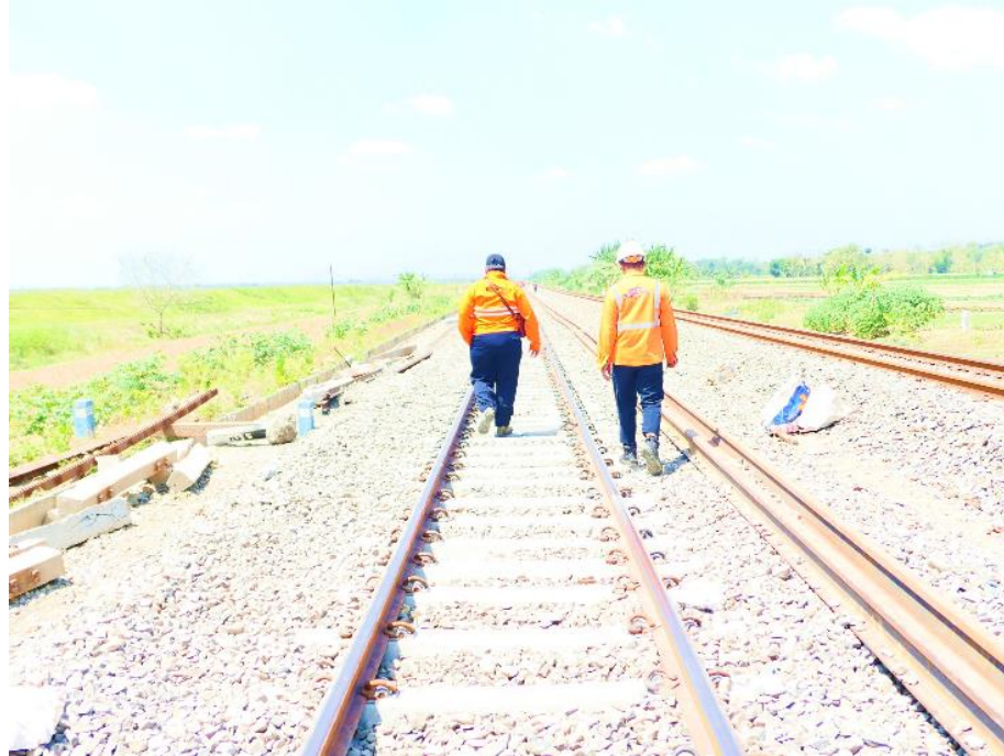
Gambar 3. Lokasi kejadian jalur hilir petak jalan antara St. Sedadi – St. Karangjati
