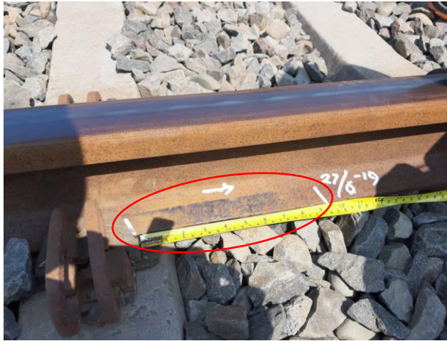
Gambar 5. Tanda gesekan pada kaki rel sepanjang \pm 24 cm
