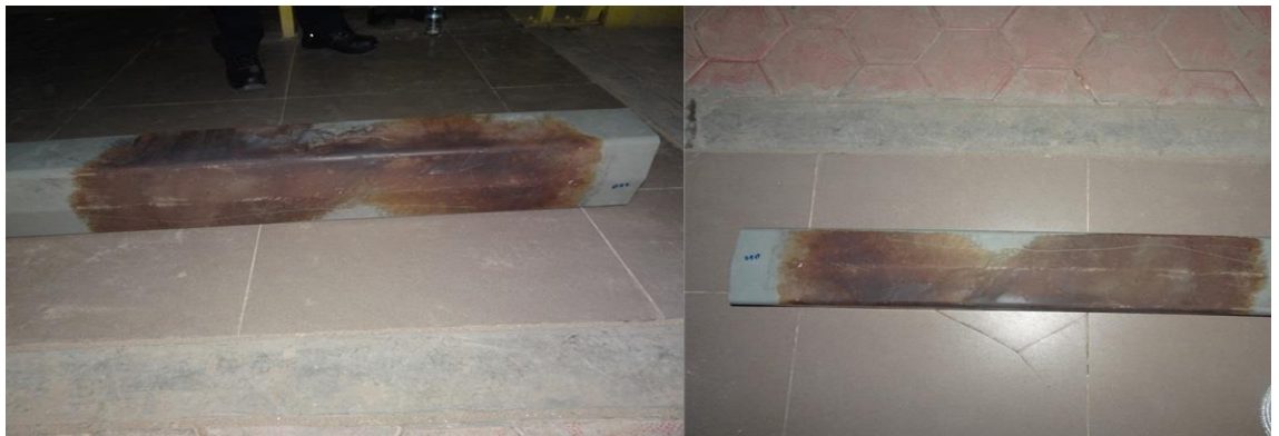
Gambar 34. Penutup Third Rail pada Sisi Prasarana
