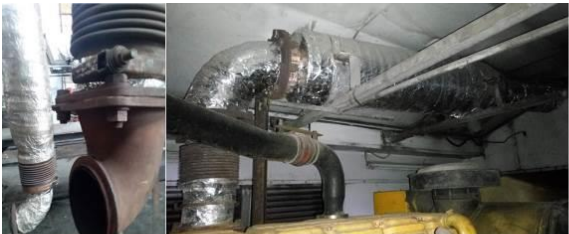
Gambar 18. Perlindungan Hot Surface Area
