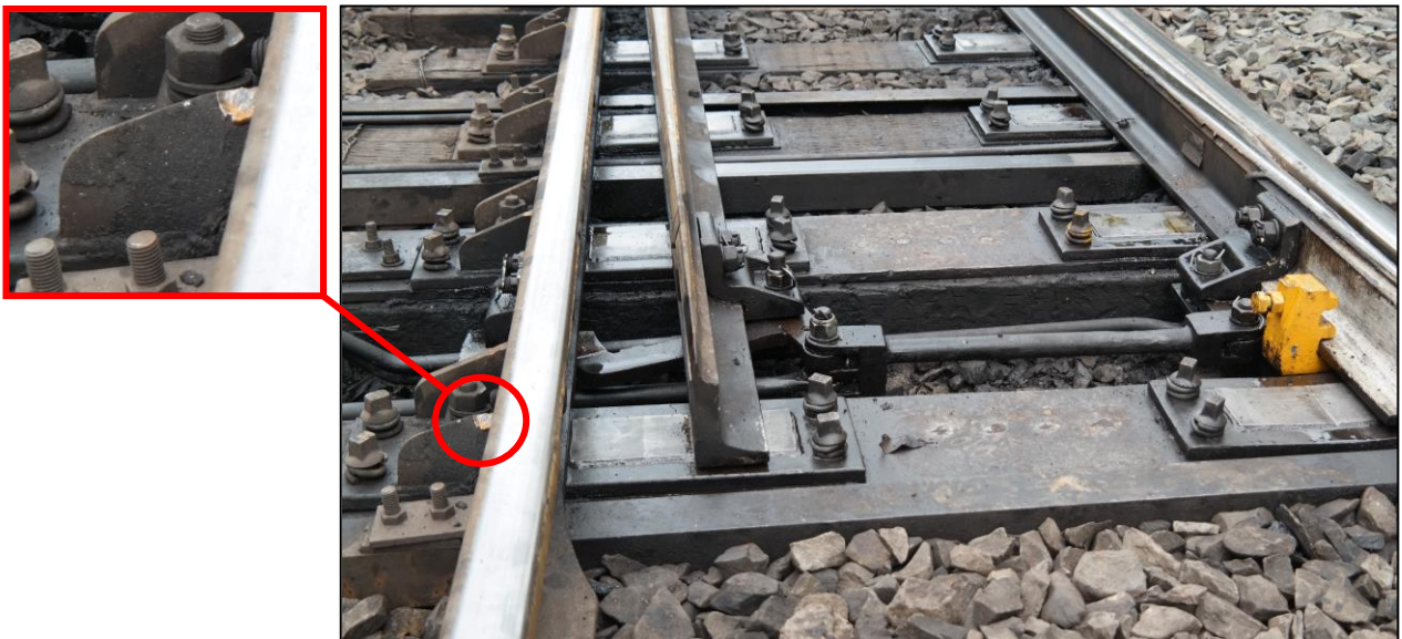
Gambar 7. Rail Brace yang Tertabrak Roda KA 3031C
