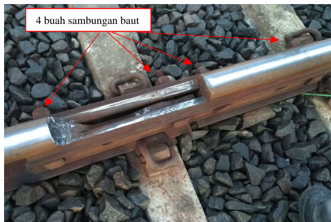
Gambar 7. Konfigurasi sambungan dengan 4 buah baut
