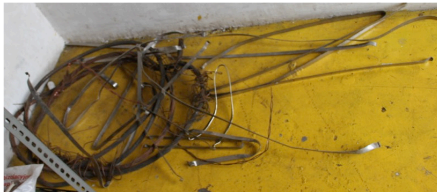
Gambar 3. Hanger dan dropper dari lokasi kejadian
