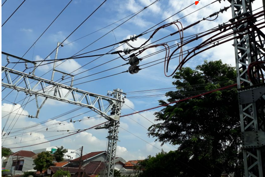
Gambar 24. Messenger wire dengan klem buaya untuk pematian kawat (atau cone-type dead-end clamp )
