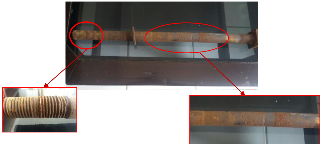
Gambar 4. Kondisi Baut Wesel 39 AB
