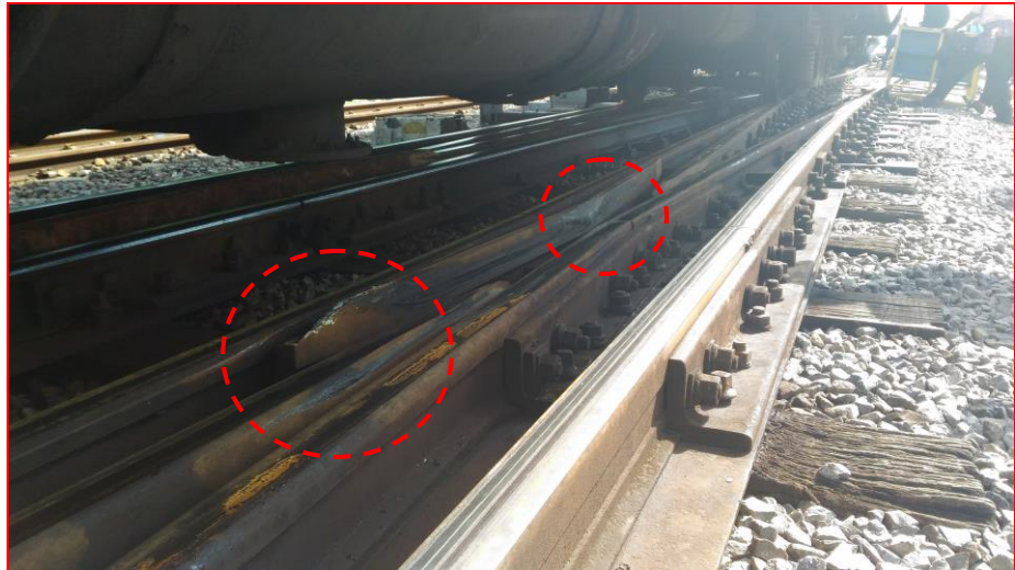
Gambar 11. Lidah wesi 39AB Yang Bergerak Saat Dilewati Kereta
