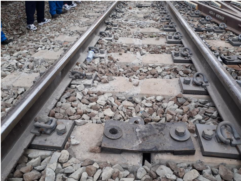
Gambar 14. Bantalan beton diikat plat
