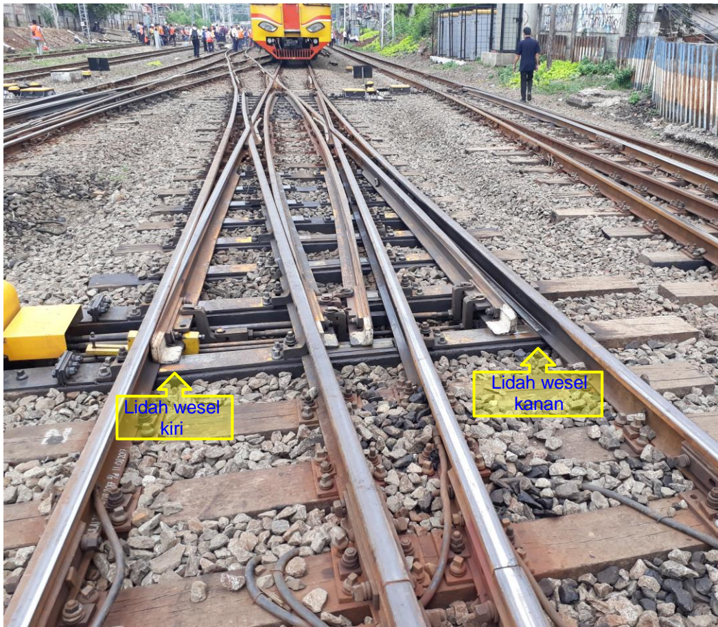
Gambar 12. Posisi Lidah Wesel 11A 3 setelah kejadian anjlokkan: lidah wesel kiri menutup dan lidah wesel kanan membuka
