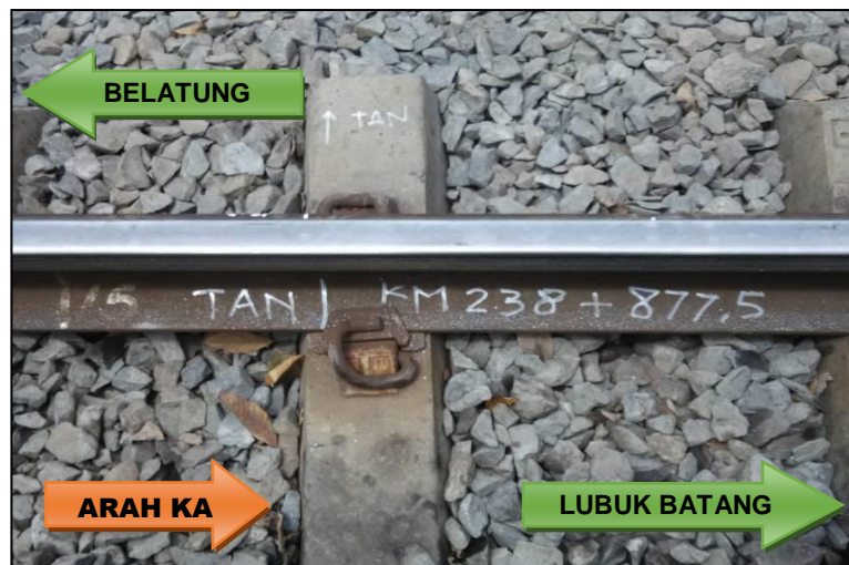
Gambar 8. Titik Awal Naik roda di km 238+877,5 di Emplasemen Stasiun Lubuk Batang
