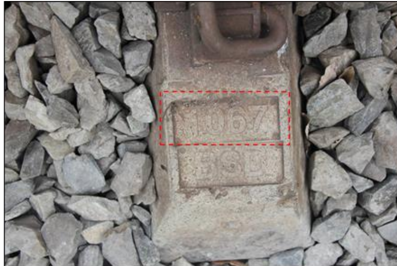
Gambar 5. Bantalan dengan lebar 1067 mm di lengkung nomor 114
