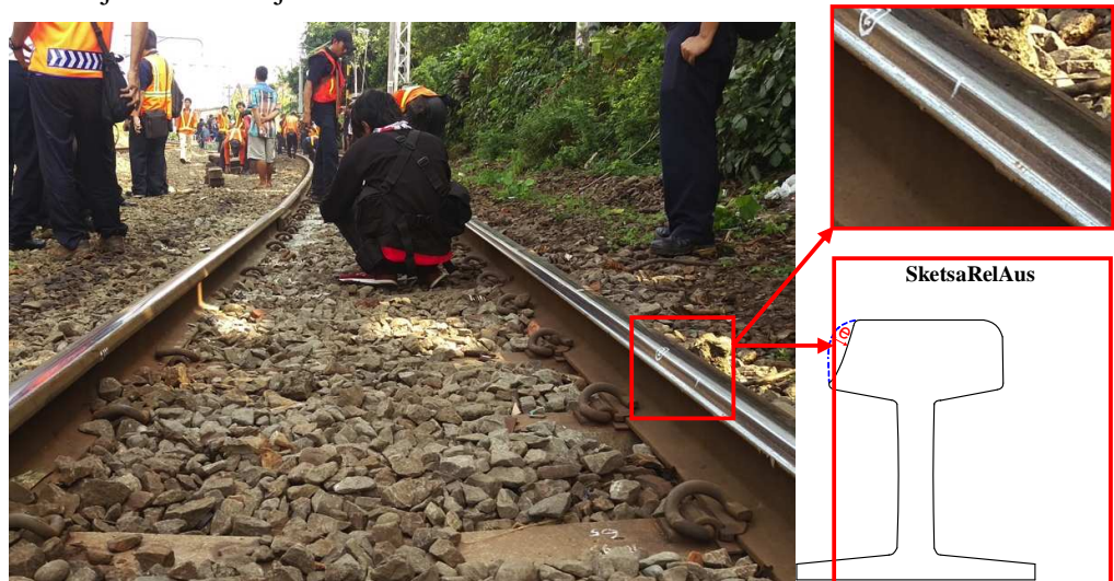
Gambar 6. Keausan rel di lokasi anjlokkan
