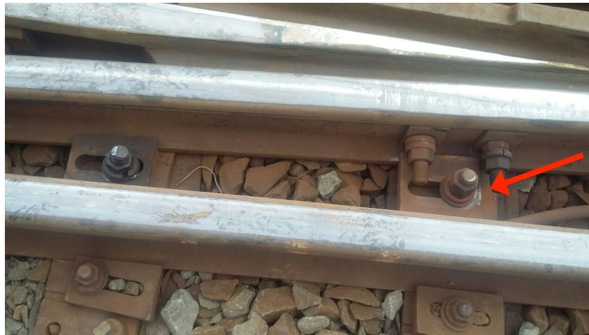
Gambar 14. Marking baut pada baseplate
