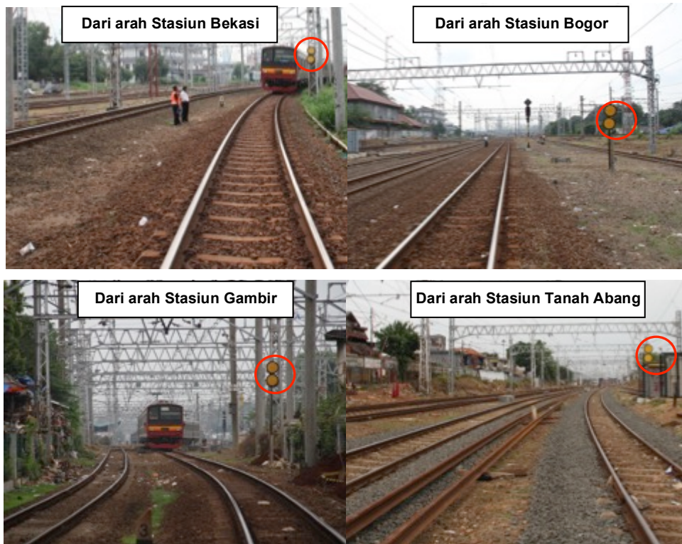
Gambar 6. Semboyan 2B yang dipasang sebelum memasuki Emplasemen Stasiun Manggarai
