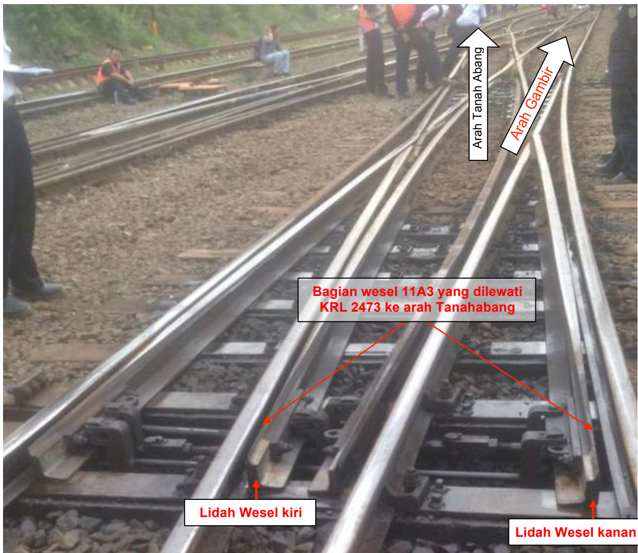
Gambar 9. Posisi Lidah Wesel 11A3 setelah kejadian anjlok
