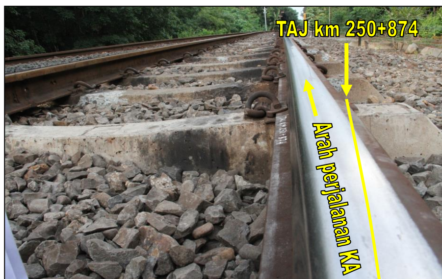
Gambar 11. Titik Awal Jatuh roda di km 250+874 di Emplasemen Stasiun Blimbimgairkaka
