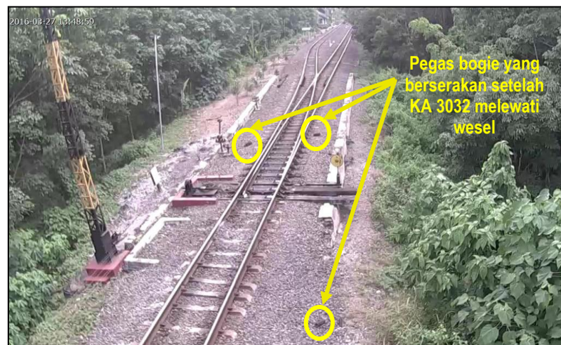
Gambar 8. Pegas bogie yang berserakan setelah terjadinya anjlok
