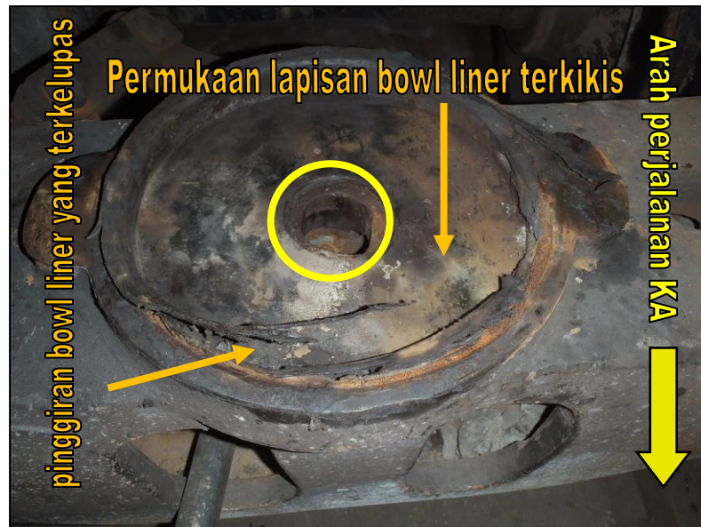
Gambar 12. Deformasi plastis dari lubang center plate dan kerusakan bowl liner pada bogie depan gerbong GB 50 86 254 yang anjlok
