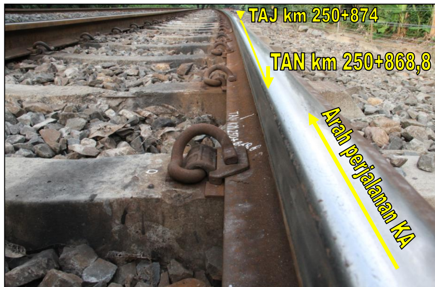
Gambar 10. Titik Awal Naik roda di km 250+868,8 di Emplasemen Stasiun Blimbimgairkaka
