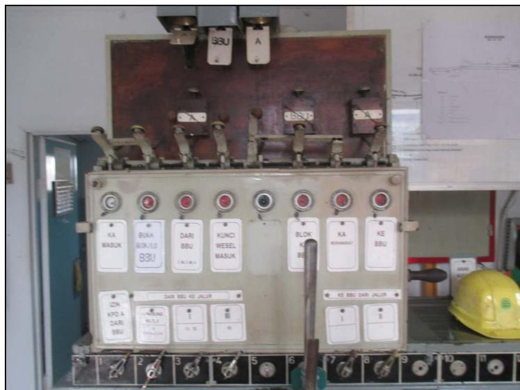
**Gambar 5.** Peralatan blok untuk hubungan blok dengan St. Blambanganumpu pada Pos P St. Negeriagung
