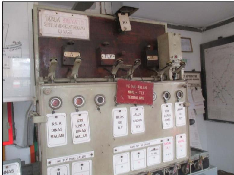
**Gambar 6.** Peralatan blok untuk hubungan blok dengan St. Tulungbuyut pada Pos P St. Negeriagung
