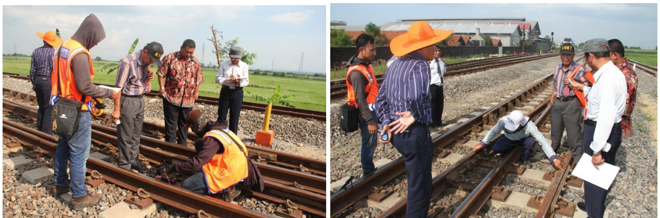
Gambar 10. Pengukuran Tegangan dan Percobaan Hubung Singkat Track Circuit 11BT
