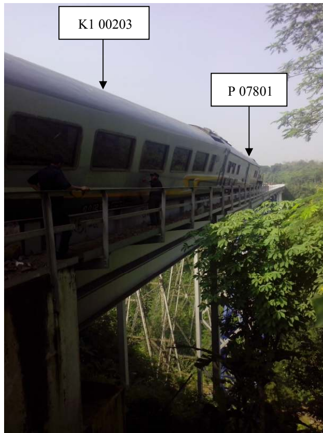
Gambar 5. Kereta P 07801 dan K1 00203 KA PLB 30A anjlok di BH 455 Jembatan Cisomang
