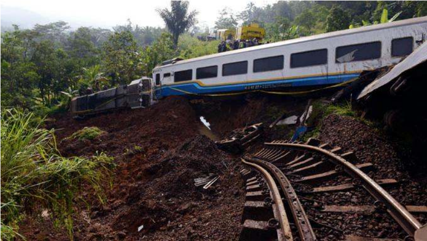
Gambar 3. Kondisi longsor di lokasi kejadian
