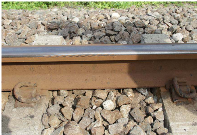
Gambar 3. Bekas benturan bull gear pada sisi dalam kepala rel
