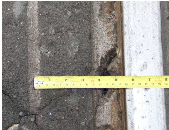
Gambar 14. Bekas gerusan plat T pada aspal perlintasan JPL 324
