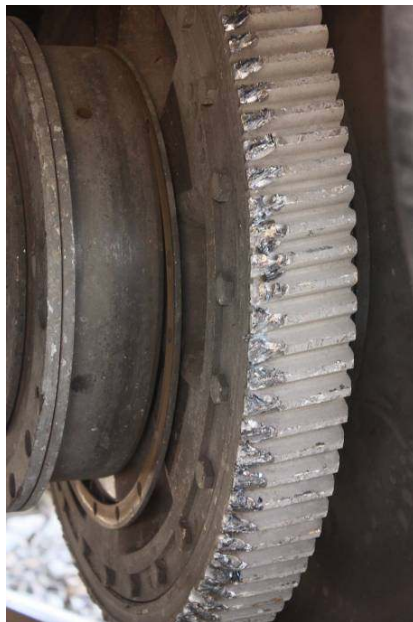
Gambar 8. Kerusakan pada bull gear yang ada pada bogie II sebelah kiri depan
