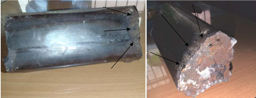
Gambar 10. Permukaan gompalan ujung kepala rel sebelah kanan yang terlihat lebih cekung ke dalam karena benturan roda kereta yang berulang-ulang
