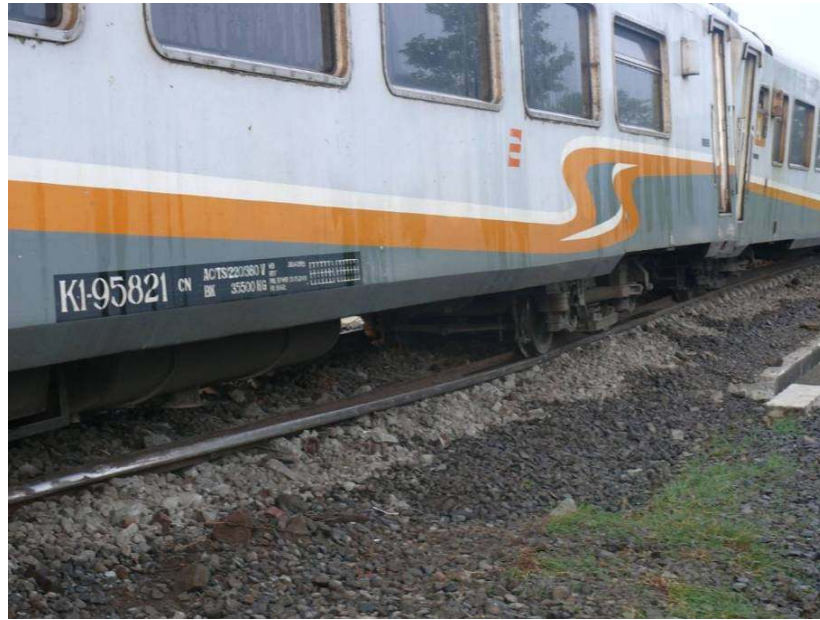
Gambar 5. Rel rebah sepanjang \pm 200 m
