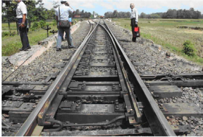
Gambar 3. Kondisi wesel baik tidak mengalami kerusakan.
