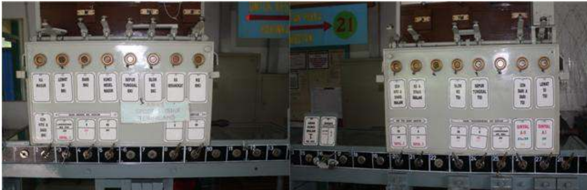
Gambar 5. Sistem persinyalan di ruang PPKA
