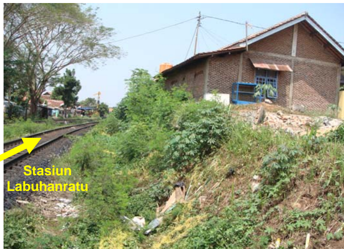
Gambar 6. Bangunan di sekitar jalan KA Stasiun Labuhanratu
