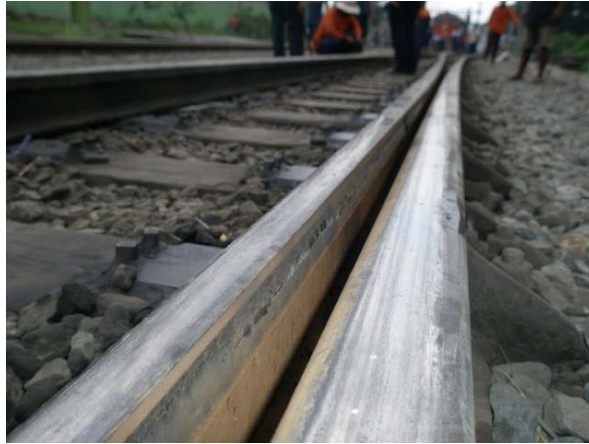
Gambar . Goresan pada sisi dalam lidah akibat roda lokomotif yang menyelip diantara lidah dan rel lantak
