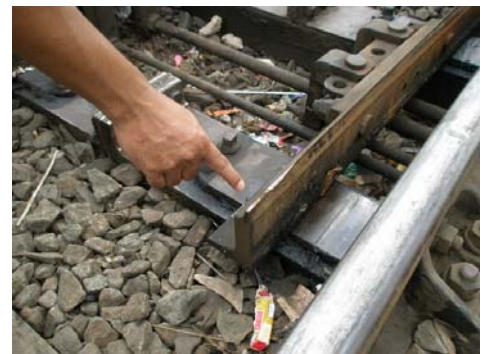
Gambar . Marking pada ujung lidah wesel
