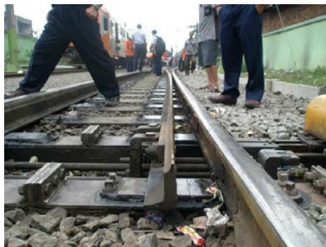
Gambar . Marking pada ujung lidah wesel
