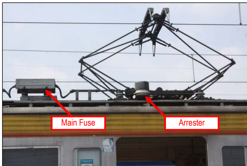
Gambar 5. Main fuse 1000A dan Arrester
