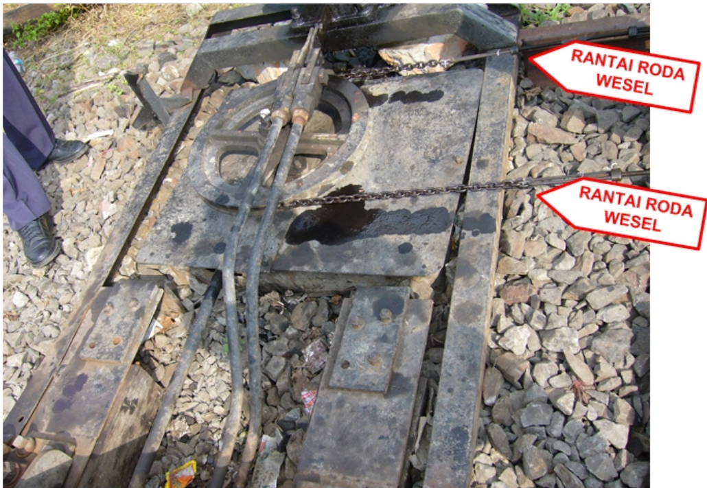
Gambar 3. Kawat kembar pada perangkat wesel terlayan pusat
