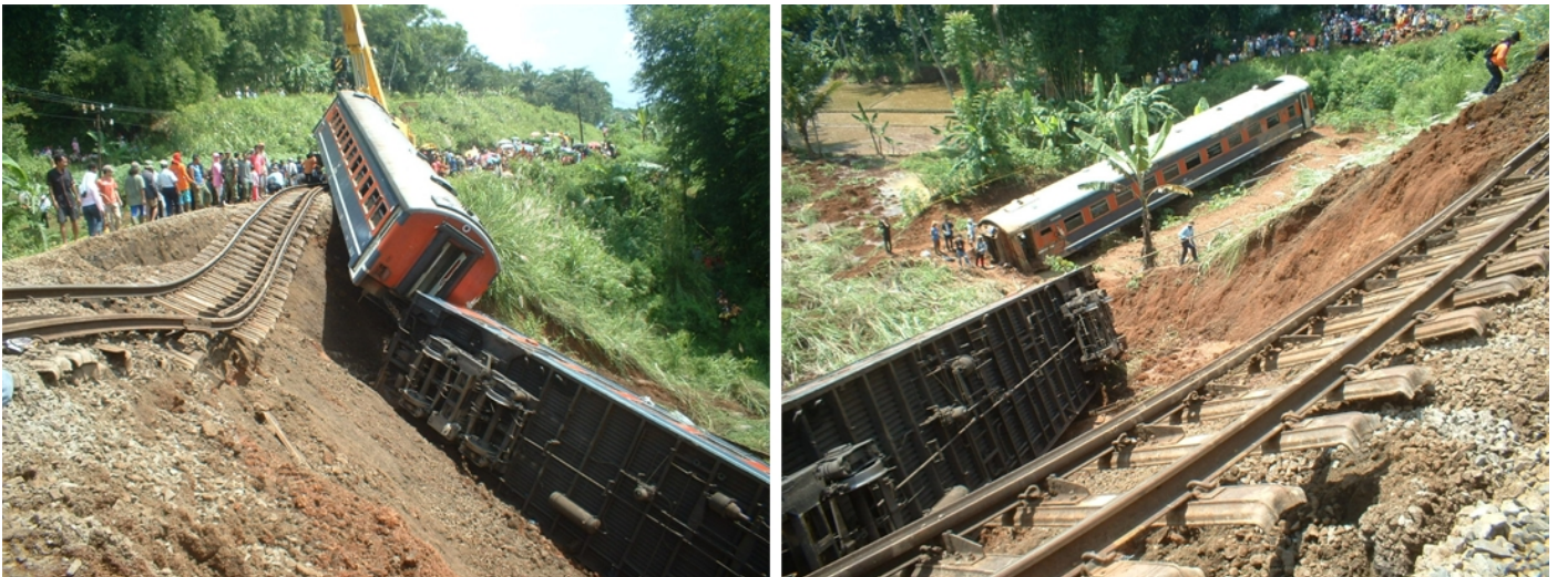
Gambar 1 . KA 174A Anjlok di Km 223+4/5 petak jalan antara Stasiun Warungbandrek - Bumiwaluya
