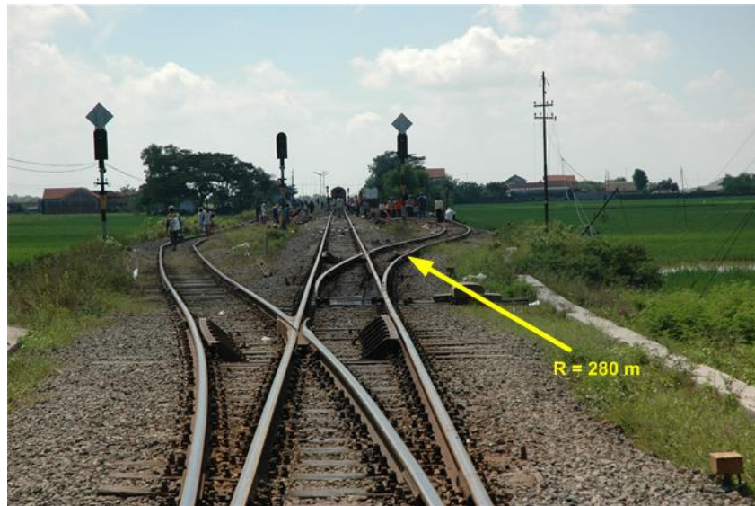
Gambar : Emplasemen Suradadi dilihat dari arah Larangan dengan lengkungan R 280 m pada sepur 3
