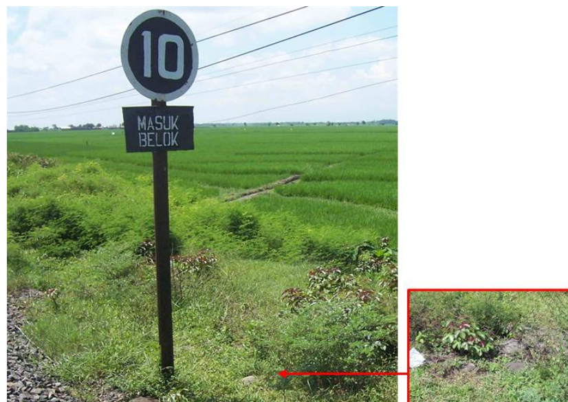
Gambar : Taspat 10 Km/jam untuk masuk sepur belok (inset: bronjong dimuka Taspat 10 Km/jam)
