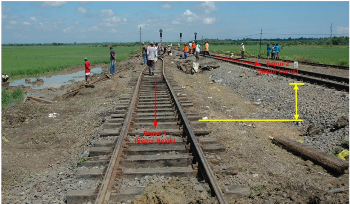
Gambar : Perbedaan ketinggian/elevasi sepur 3 (sepur belok) dengan sepur 2 (sepur lurus)
