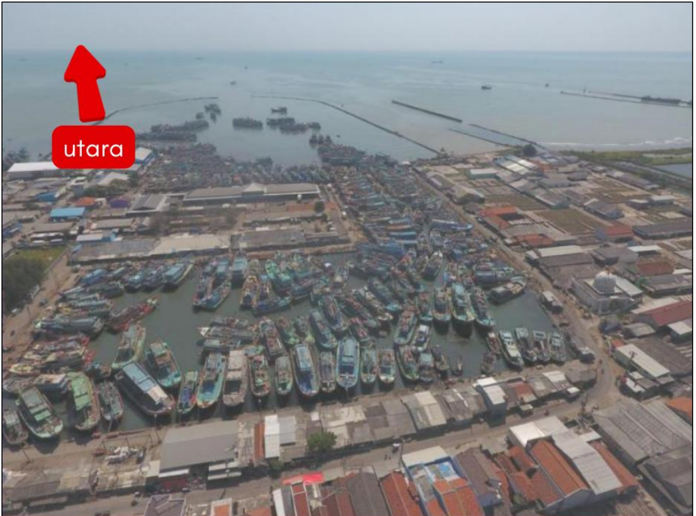
Gambar 1 Kondisi Pelabuhan Perikanan Pantai Tegalsari Lima Hari Sebelum Kejadian
