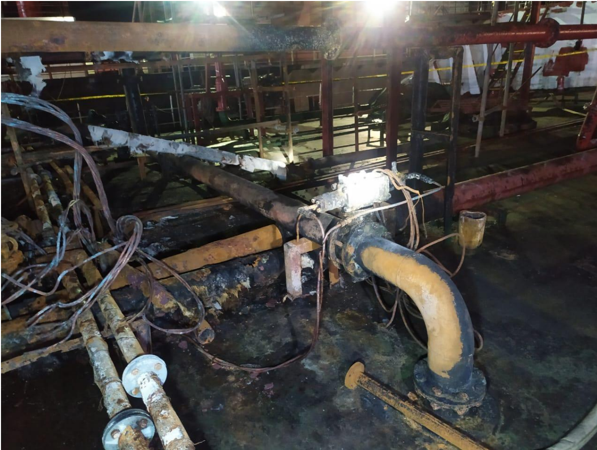
Gambar 7. Geladak Utama Area Tengah COT No. 1
