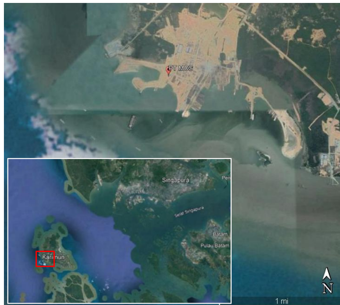
Gambar 1. Lokasi Galangan PT MOS
