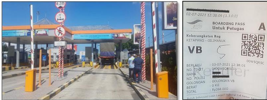
Gambar I-23: Gerbang masuk Pelabuhan Ketapang yang dilengkapi dengan jembatan timbang, marka pembatas ukuran kendaraan dan contoh bukti tiket kendaraan kapal penyeberangan
