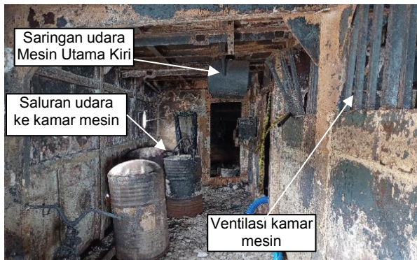
Gambar I- 13 Geladak 1 Kiri Dekat Kamar Mesin
