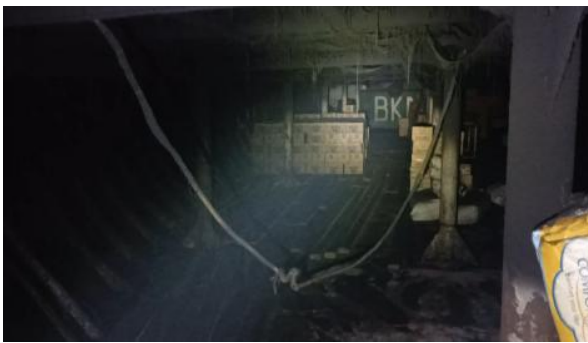
Gambar I-6 Kondisi Ruang Muatan
