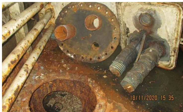
Gambar I-44: Manhole cover tangki nomor 2 SWBT sebelah kanan
