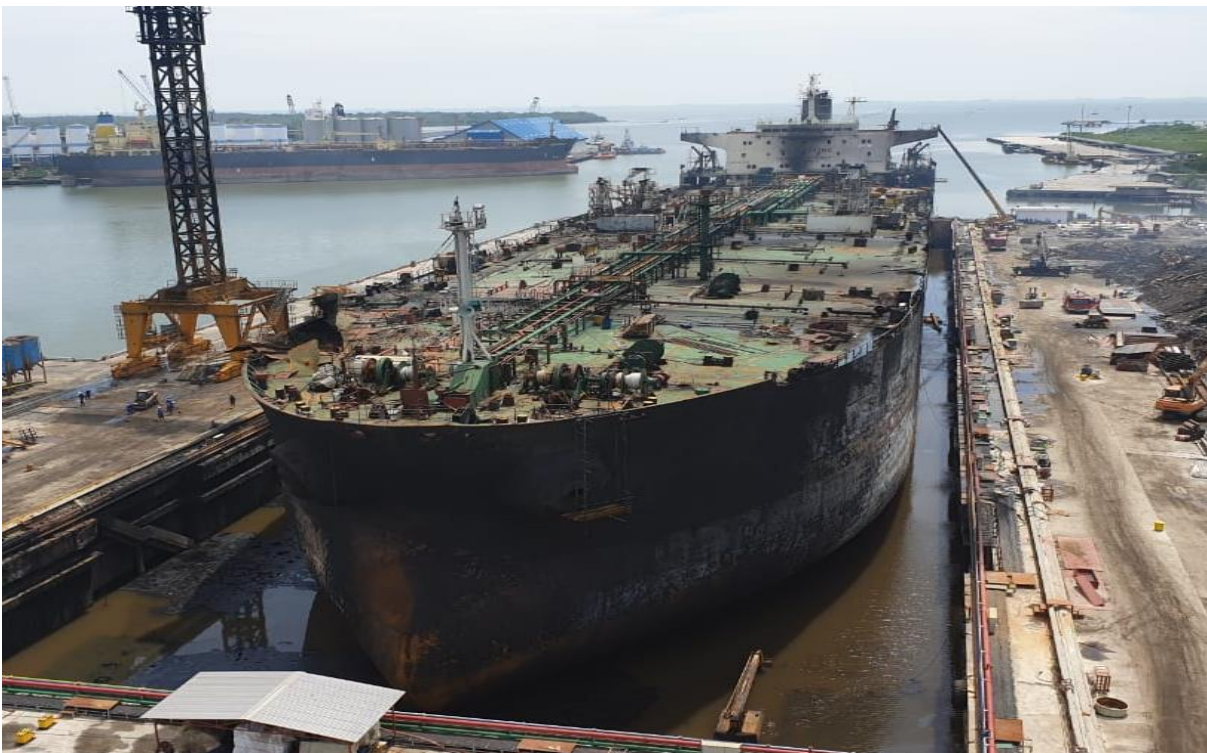
Gambar I-3: Kondisi Jag Leela setelah pemadaman kebakaran
