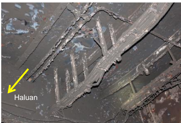
Gambar I-22: Instalasi Listrik di Atas Truk A
