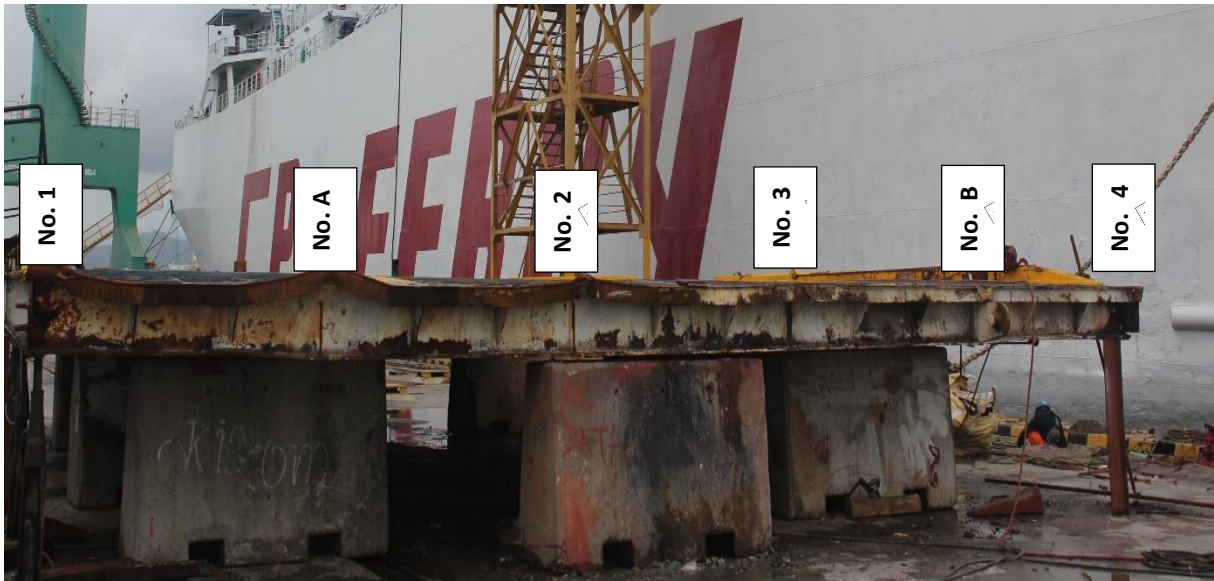
Gambar I-9: Perbaikan pintu rampa buritan
