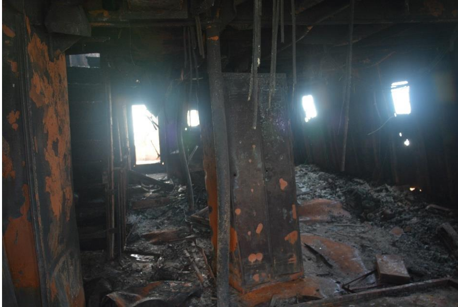
Gambar I-3: Kondisi akomodasi awak kapal setelah kejadian
