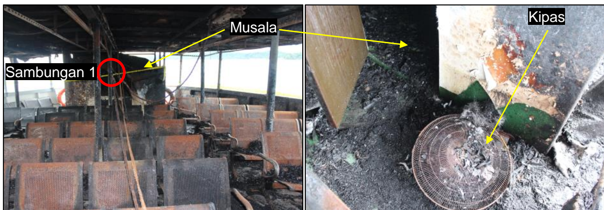
Gambar I-4 Kerusakan di Tempat Penumpang dan Musala (Pandangan dari Haluan)
