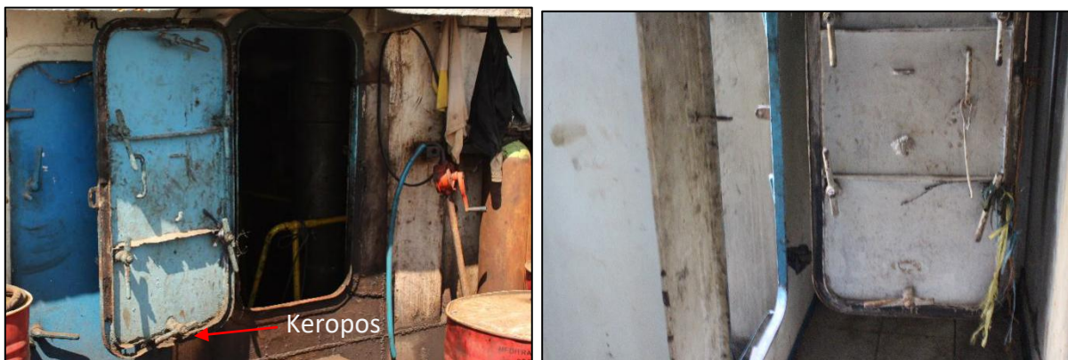
Gambar I- 6: Kiri: Pintu ke kamar mesin di buritan kapal; Kanan: Pintu ke kamar mesin di dalam bangunan akomodasi
