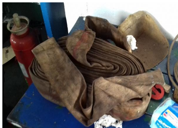
Gambar 8: Slang (hose) hidran tanpa kopleng
