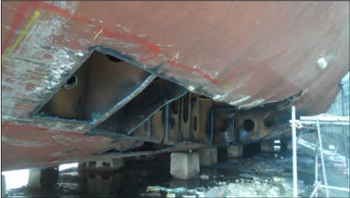
Gambar I-10: Pekerjaan replating pada lambung kapal yang rusak (kiri)
