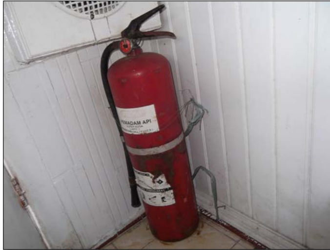
Gambar I-7 : Pemadam kebakaran jinjing jenis Busa (foam liquid AFFF) 10 liter (Gambar diperoleh dari Kantor UPP Kelas I Baubau)
