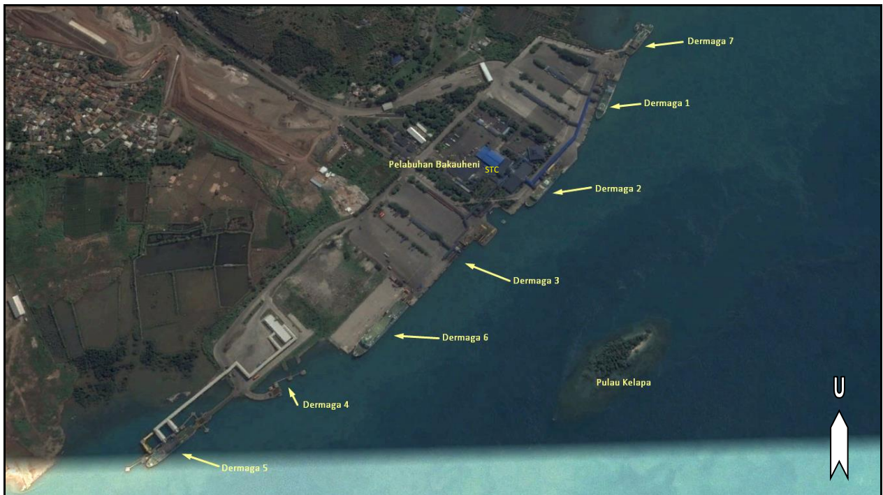
Gambar 6: Pelabuhan Penyeberangan Bakauheni (letak Dermaga 3 dan 6 berdekatan) (sumber: Google earth)
