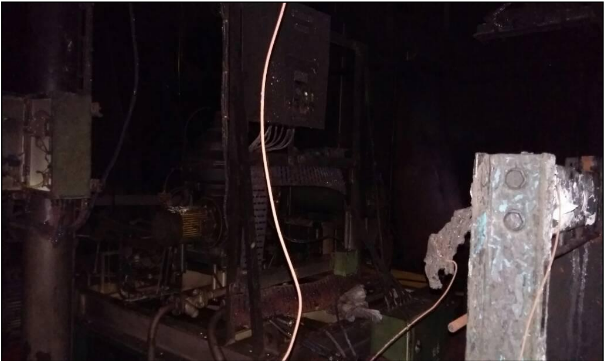
Gambar I-20: Perlengkapan permesinan habis terbakar
