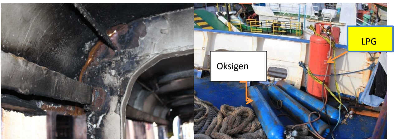
Gambar I-4: Area pekerjaan Panas KM. Geovani
