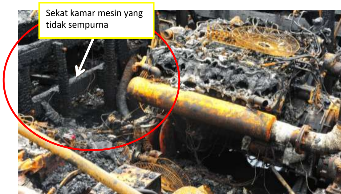
Gambar I-26: Kondisi sekat depan kamar mesin
