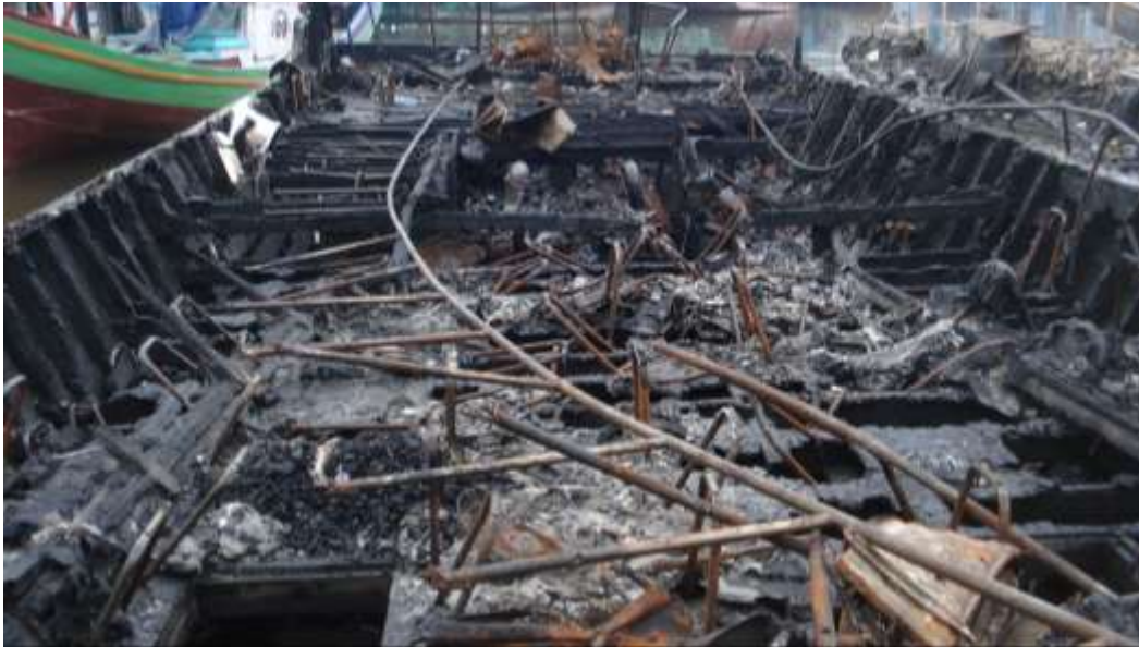
Gambar I-13: Kondisi geladak utama KM. Zahro Express setelah terbakar
