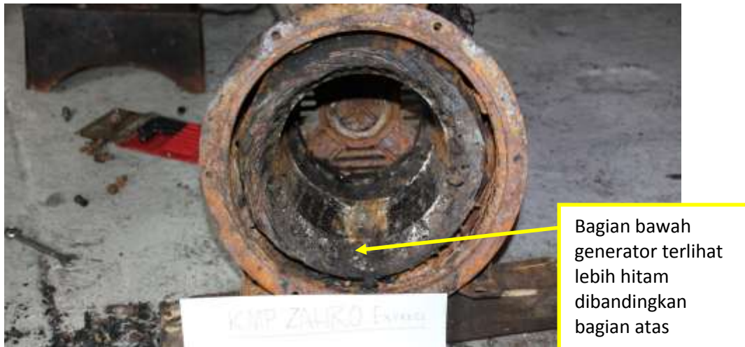
Gambar I-33: Pemeriksaan Stator Generator Listrik
