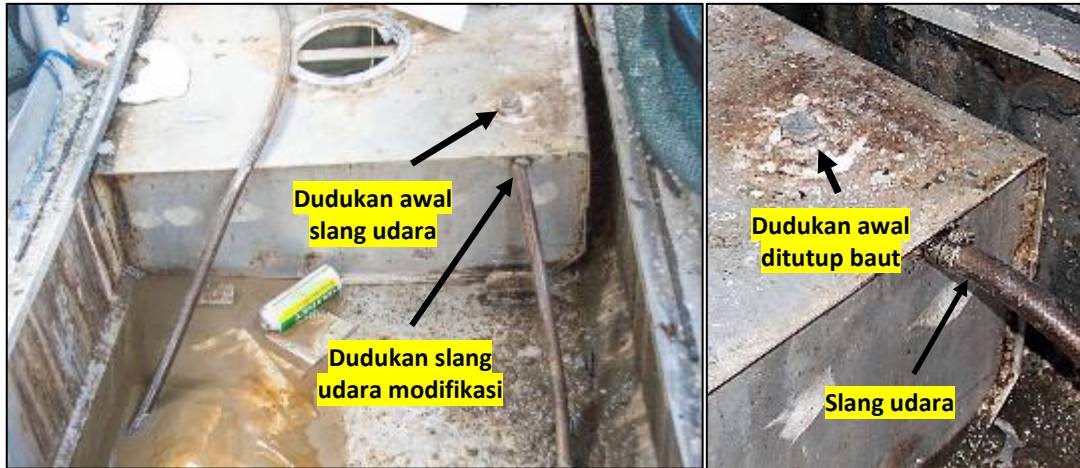
Gambar I-25: Kondisi selang udara tangki Kapal Gili Cat II.
